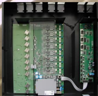
Coffret interface avec les terminaux de paiement et les distributeurs
